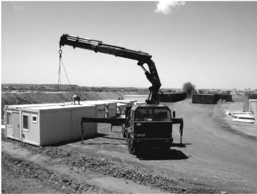
Fotografia 6. Jelcz HIAB wykorzystywany do składania kontenerów mieszkalnych
